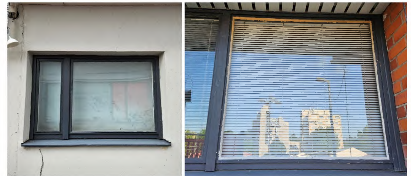
Kuva 92. Puupuitteiset, alkuperäiset ikkunat rakennuksen eteläpäädyllä (vas.) ja torin puolella (oik.)
