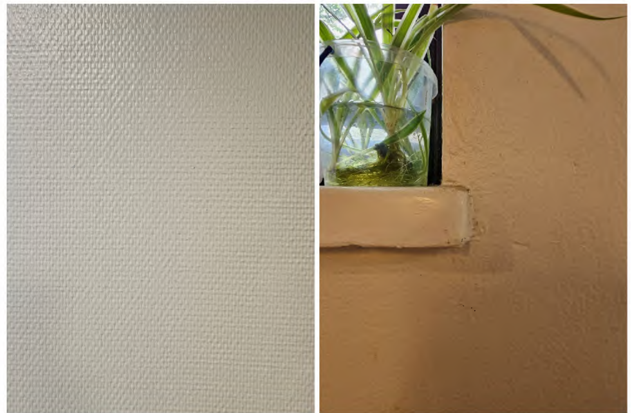
Kuva 109. Huoltokäytävän maalatut seinät. Osa seinäpinoista on päällystetty lasikuitutapetilla (vasemmalla).
