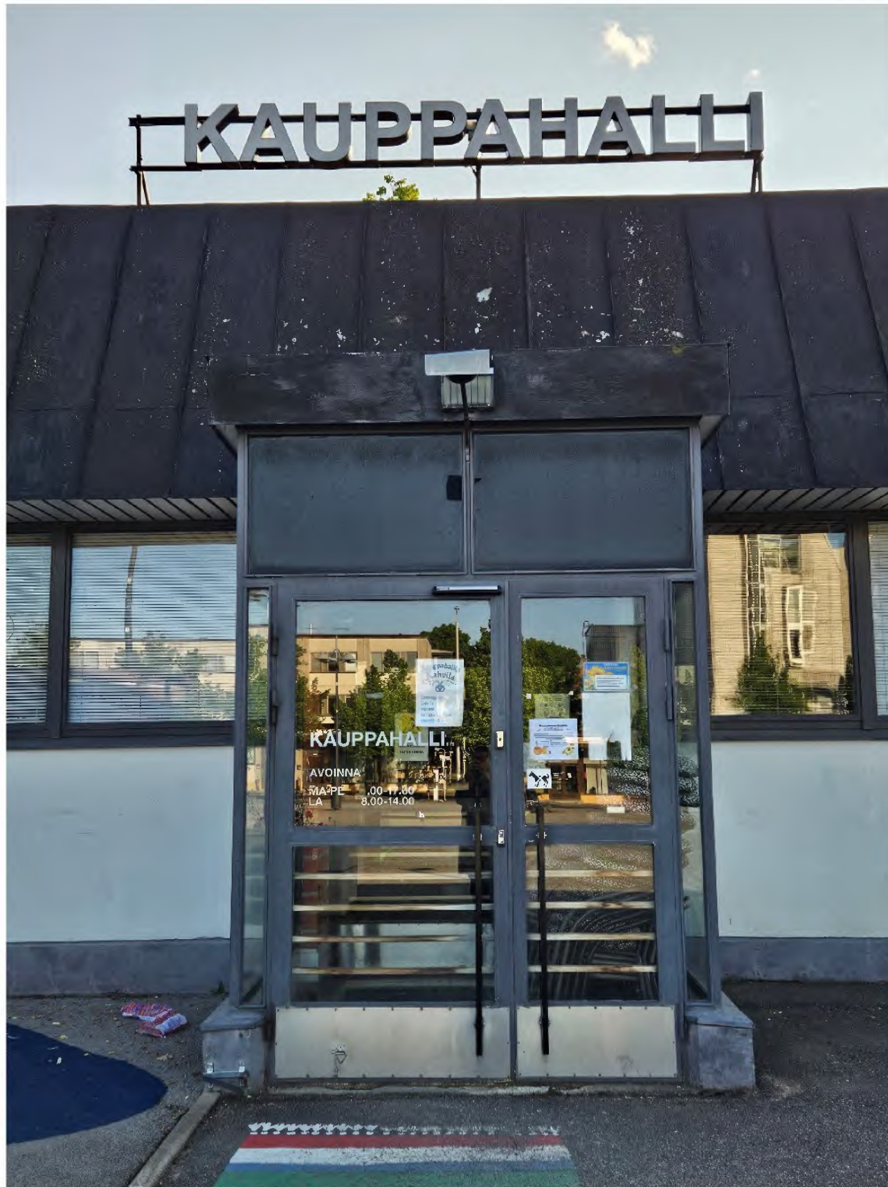
Kuva 87. Muutostyönä 1967 lisätty sisäänkäynti, johon kuuluu lasiseinäinen tuulikaappi. Sisäänkäynti johtaa kauppahallin kahvilalle. Ovet on uusittu peruskorjauksen yhteydessä vuonna 2002.
