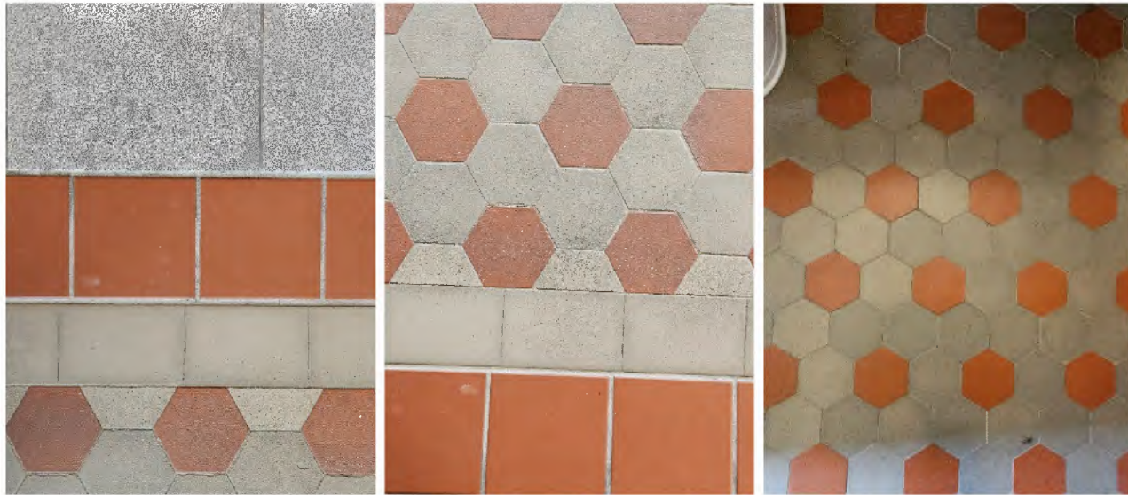
Kuva 106. Laatoituksia kauppahallin asiakaskäytävällä (2 kuvaa vasemmalla) ja yleisessä WC:ssä (oik.).
