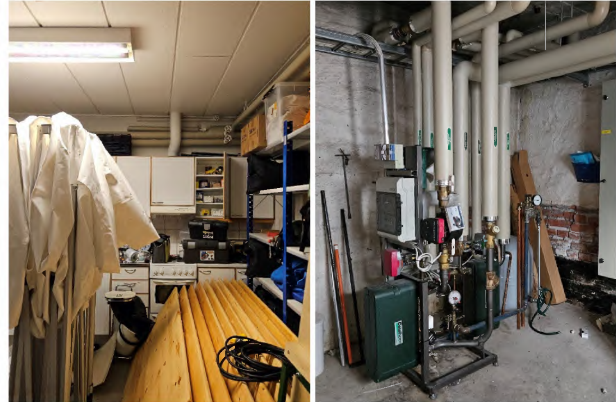
Kuva 104. Vasemmalla varastohuone ja oikealla lämpökeskus. Molemmat sijaitsevat rakennuksen eteläpäädyssä.
