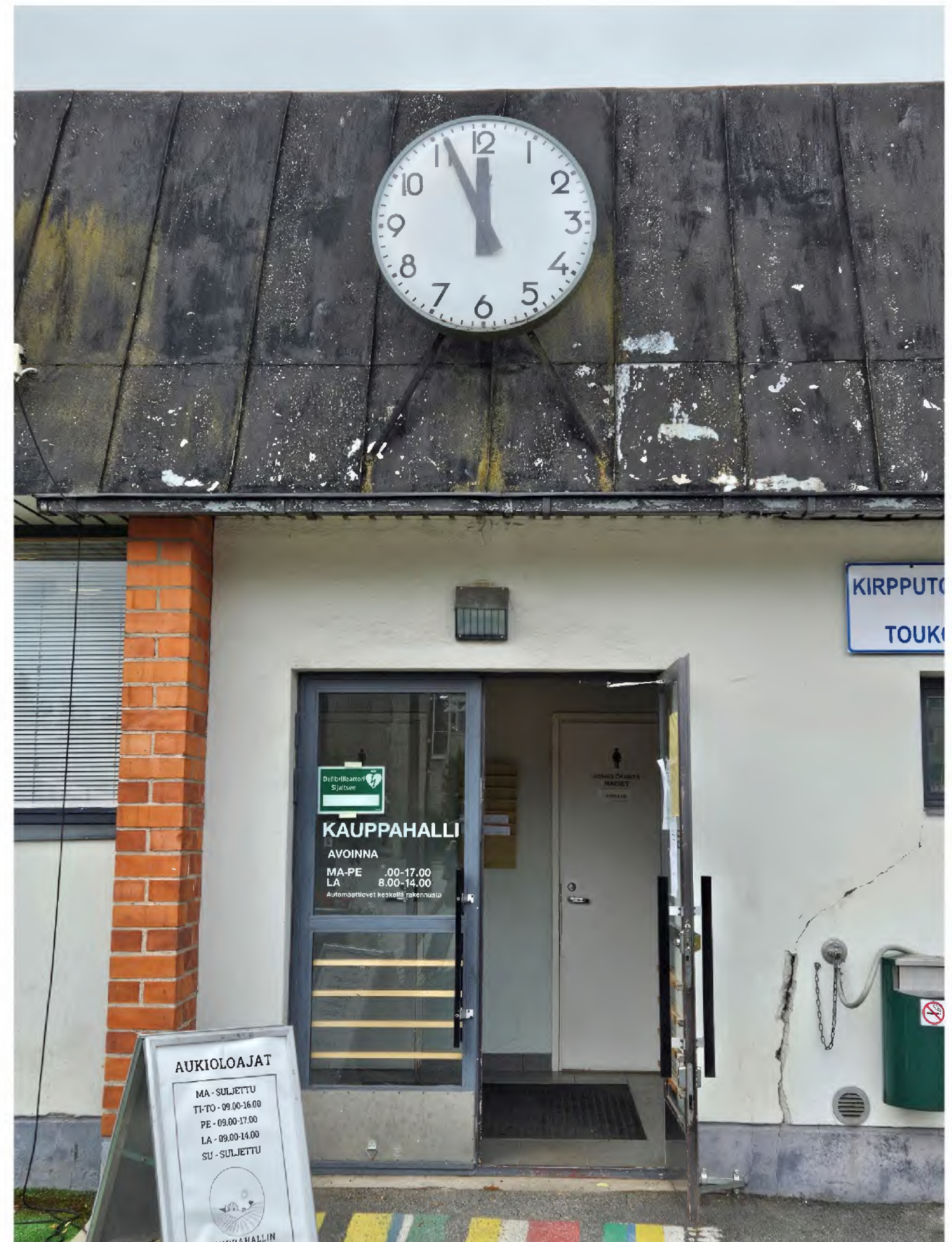
Kuva 86. Sisäänkäynti halliin torin pohjoispuolelta. Metallirunkoiset ovet ovat vuoden 2002 peruskorjauksen ajalta. Kauppahallin kello on alkuperäinen. Oven päällä oleva valaisin on uusittu.
