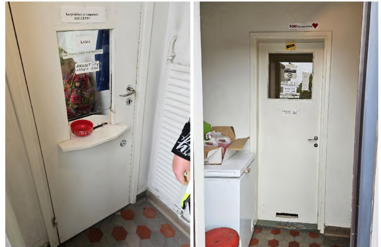
Kuva 99. Kauppahallin yleinen WC. Vasemmalla kassa, joka sijaitsee sisäänkäyntien välissä. Oikealla ovi naistenhuoneeseen.
