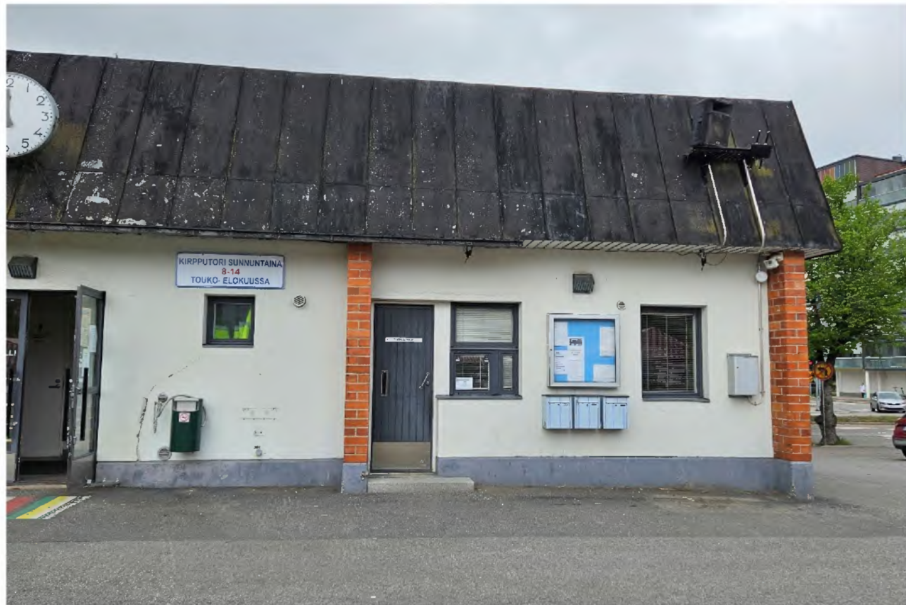
Kuva 85. Rakennuksen pohjoispääty torin puolelta. Tilassa sijaitsee torivalvojan toimisto.
