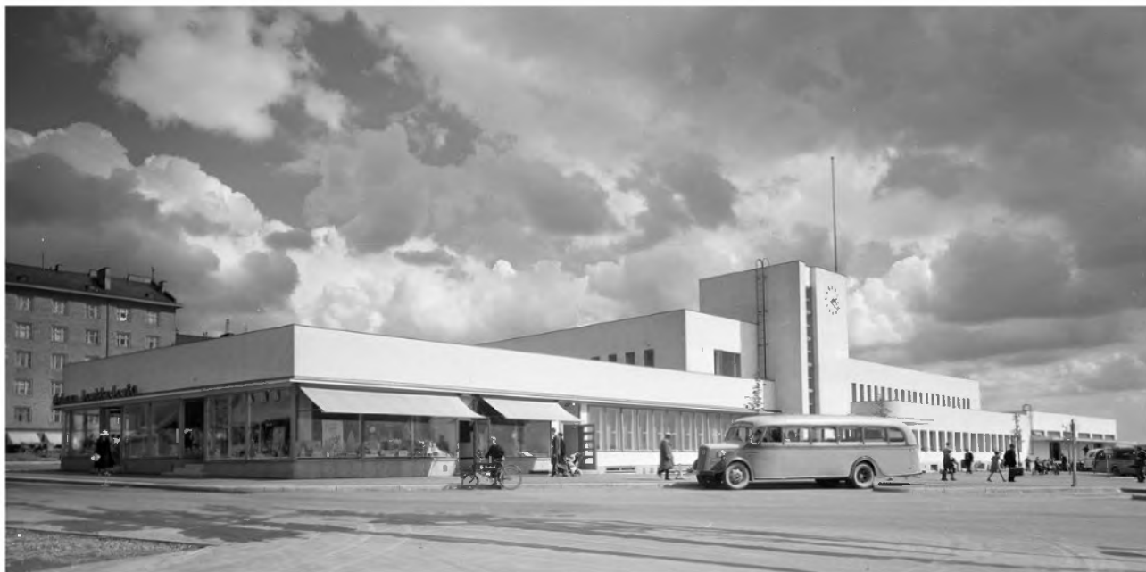
Kuva 50. Vuonna 1938 valmistunut Tampereen linja-autoasema, jonka avustavana suunnittelijana Reino Ahjopalo oli. Kuva: Aarne Pietinen, Museovirasto.
