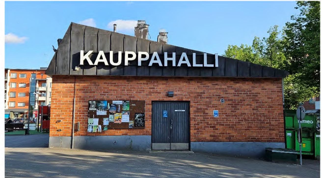
Kuva 75. Pääty pohjoiseen. Sisäänkäynti johtaa jätetuoneeseen. Kaikki pinnat ovat alkuperäisiä.
