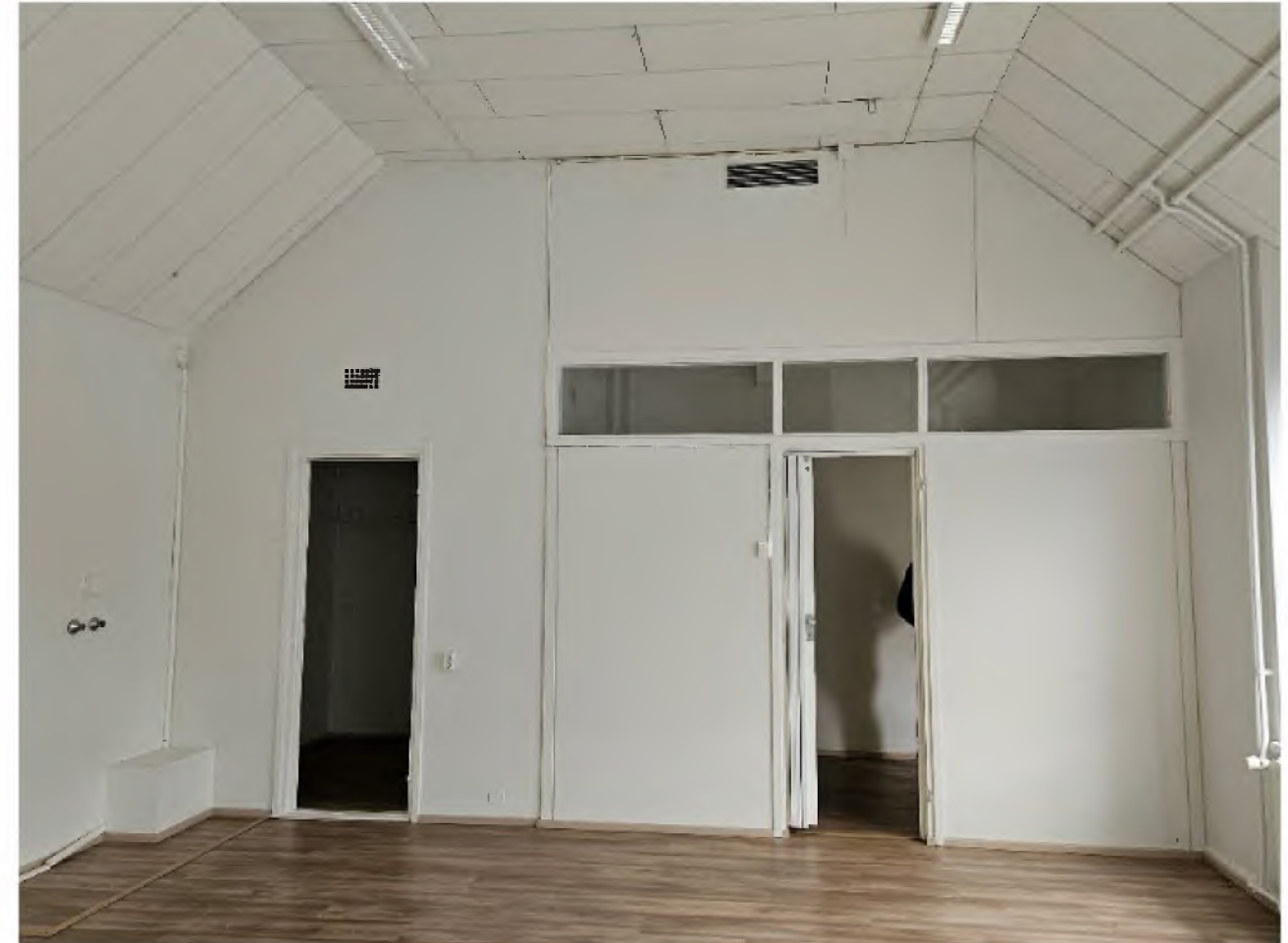
Kuva 97. Liiketila on korkeaa tilaa. Sisäkatossa on maalatut, vanhat puukuitulevyt. Lattia on päällystetty uudenaikaisella laminaatilla melko hiljattain.
