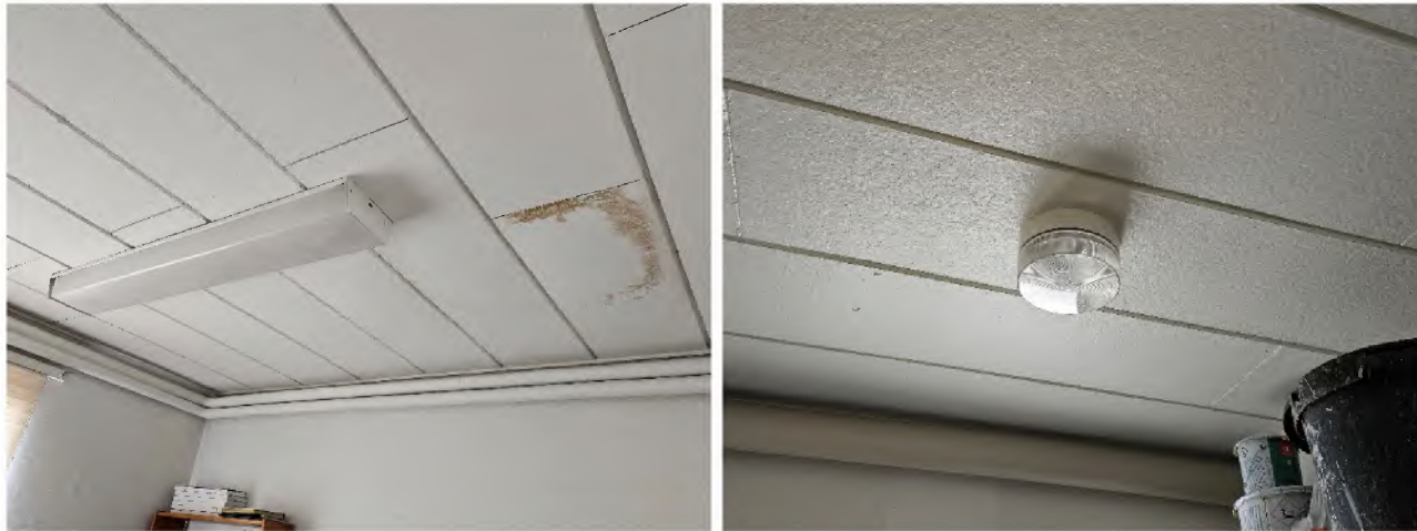
Kuva 110. Huokoista puukuitulevyä maalattuna talonmiehen asunnon ja varastojen sisäkatoissa.
