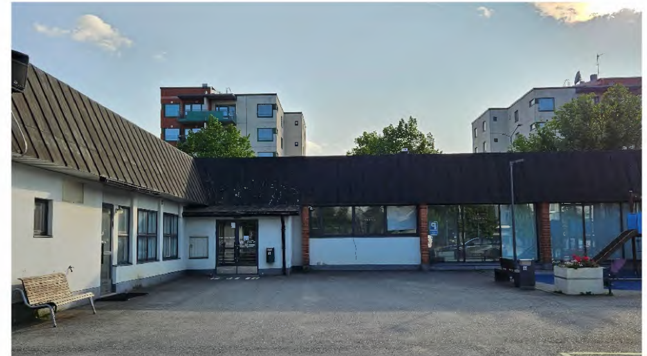
Kuva 80. Itäjulkisivua ja sivusisäänkäynti. Suuret ikkunapinnat on tehty muutostyönä 2000-luvun alussa.
