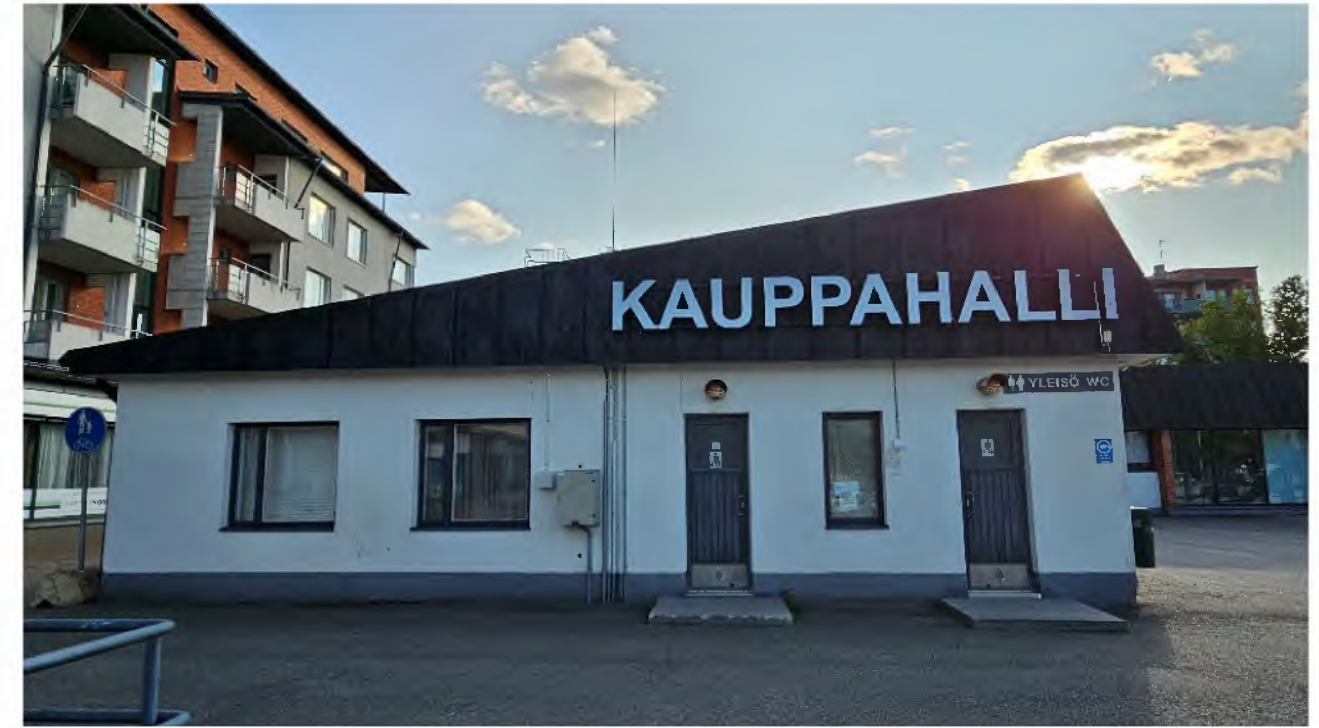
Kuva 79. Päätty itään. Vasemmalla kaksi entisen talonmiehen asunnon ikkunaa, oikealla yleisö-WC:t.
