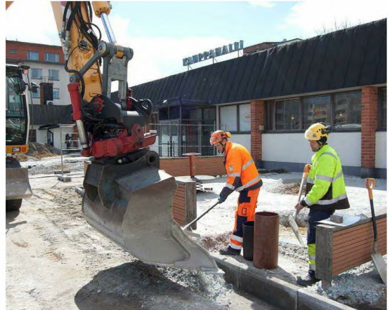
Kuva 37. Valokuva kauppahallin edustan leikkipaikan rakennustöistä vuodelta 2017. Kuva: Heikki Kempainen.
