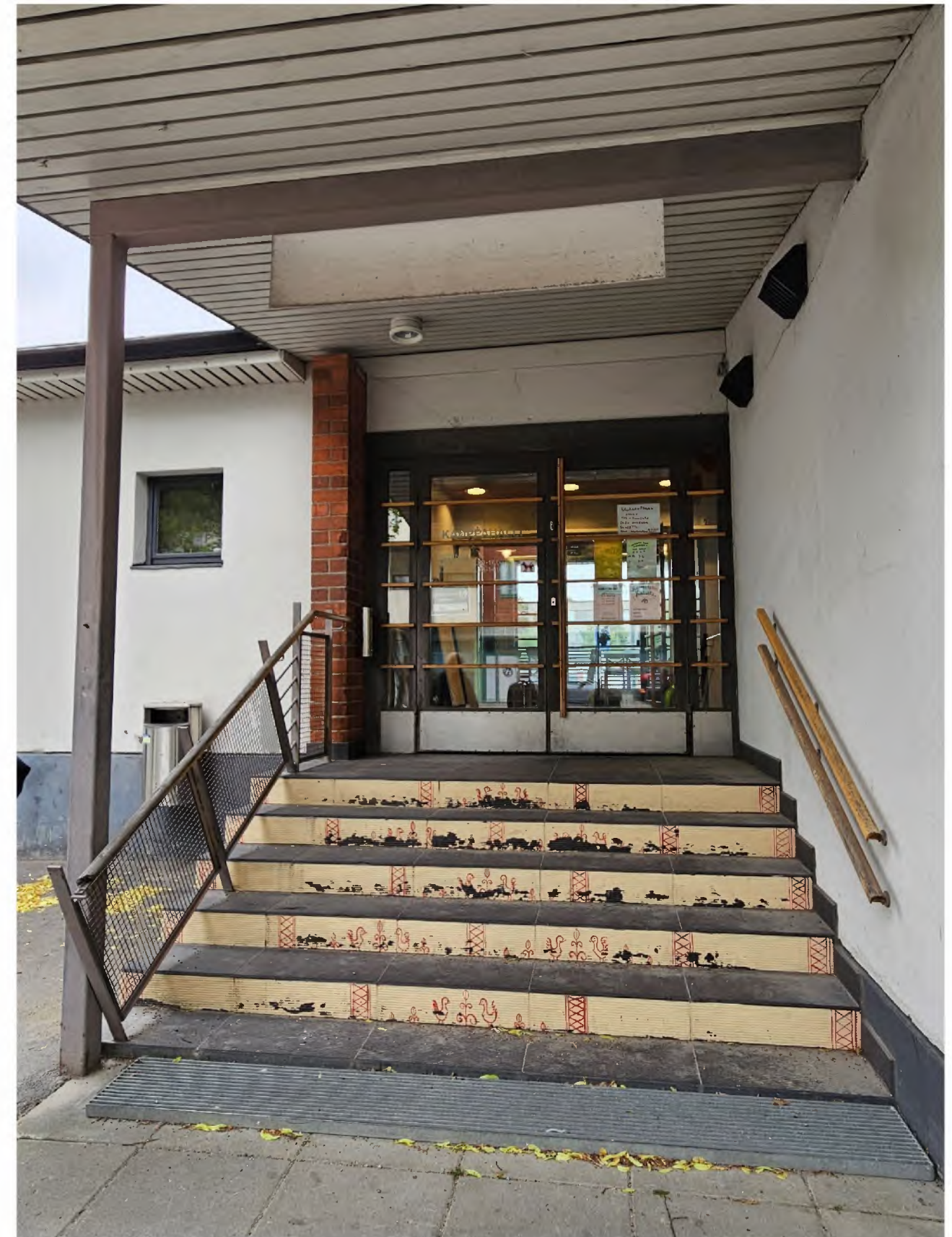
Kuva 88. Sisäänkäynti Snellmaninkadun puolelta. Ulko-ovet ja kaitteet on uusittu vuonna 2002.
