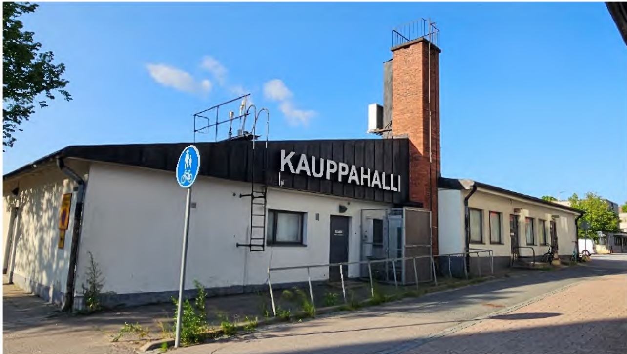
Kuva 78. Julkisivu etelään Kievarinkadulle. Oikealla olevassa osassa sijaitsee entinen talonmiehen asunto ja vasemmalla on teknisiä tiloja, kuten lämpökeskus, sekä varastotilaa.
