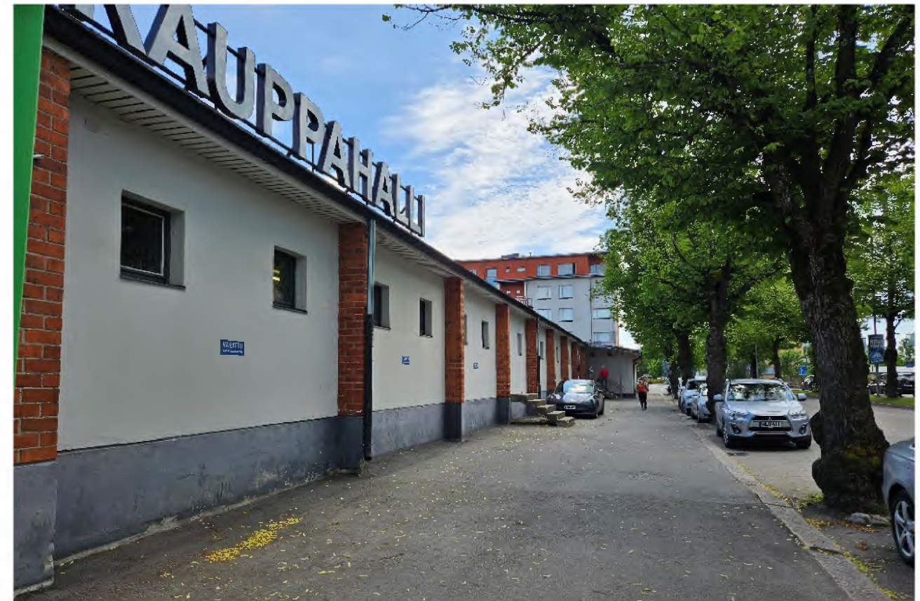
Kuva 76. Kuvissa julkisivu länteen Snellmaninkadulle. Pinnat ovat alkuperäisiä, mutta maalattuja rappauspintoja on kunnostettu.
