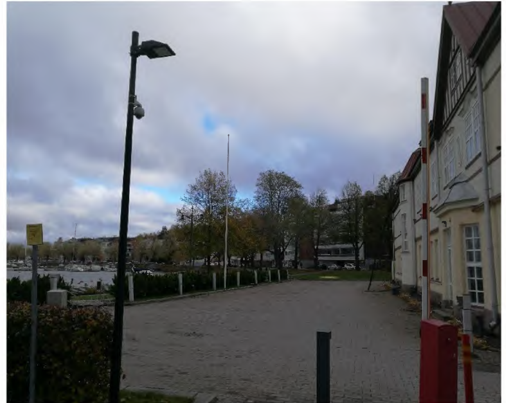
Kuva 295. Kylpylä pihan kunto rannan puolella ei täysin vastaa rakennuksen arvoa kuva 2020.
