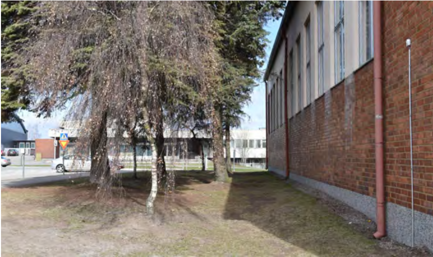
Kuva: Koulun väliosan ja Kapteeninkadun väliselle pienelle nurmialueelle on istutettu kyynelkoivu ja jalokuusia. Julkisivu näkyy Lavolankadun suuntaan.
