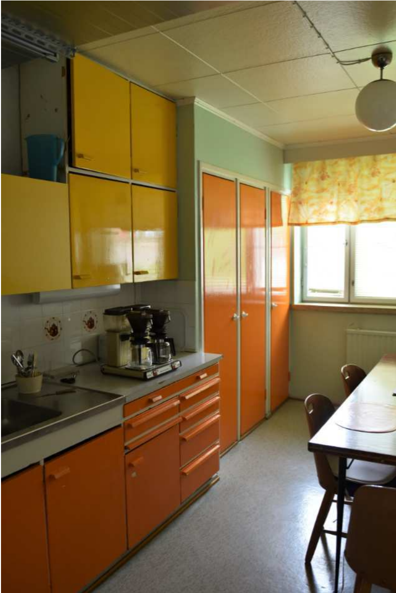
Kuva: Koulun vahtimestarin toimisto- ja sosiaalitilana olevassa huoneistossa on säilynyt alkuperäinen keittiökaapisto (vaneri, täyspuu) ja sileillä laakaovilla ja Leea-painonappisalvoilla varustetut kaapit. Matto, puulistat ja katon puukuitulevyt sekä pallovalaisin lienevät alkuperäisiä. Huoneistossa on myös vanhoja huonekaluja.
