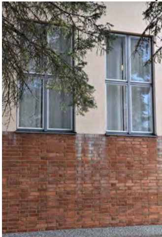
Kuva: Salin ristikarmi-ikkunat.
