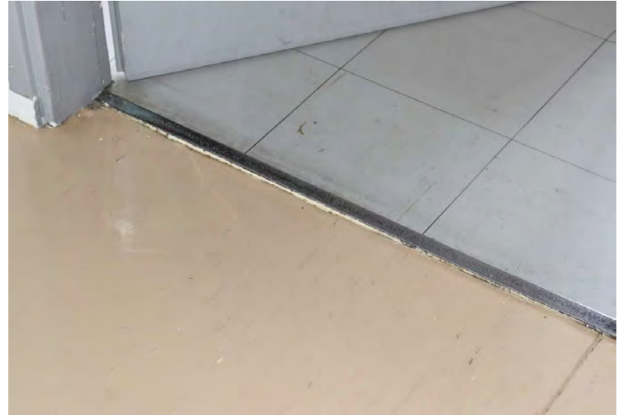
Kuva: Itäsiiven yläkerroksen käytävällä on nähtävästi vinyylilaatat, luokan puolella matto. Luokissa lattialistat ovat puuta, käytävällä muovia, kynnyks metallia.
