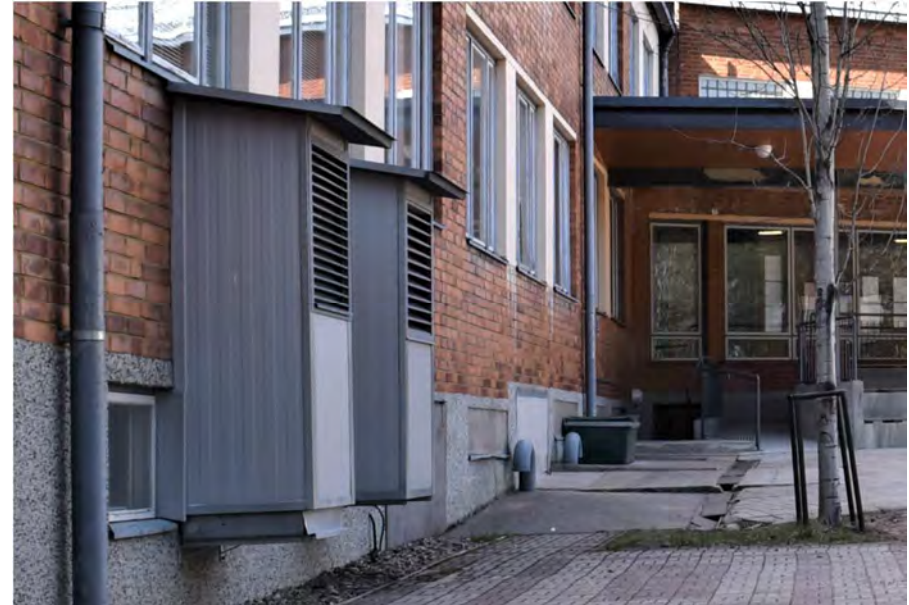
Kuva: Sokkelin ikkunoita on muurattu umpeen. Katoksen alla invaluiska. IV/imastoininkoneen suojakotelot.
