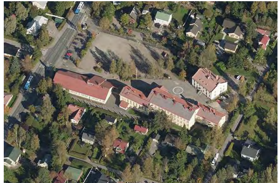
Kuva: Rekolan 50-luvun koulurakennuksessa sen keskikäytävällinen luokkasiipi on rakennuksen väliosa, ja sen kanssa samansuuntaisesti omissa siivissään sijaitsevat juhla- ja liikuntasali sekä henkilökunnan asunnot. / Kuva: Vantaan kaupunki, viistoilmakuvat 2016. Koulurakennukset.fi -sivusto
