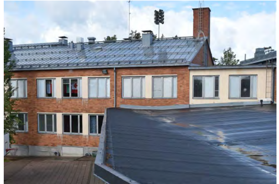
Kuva: Rakennuksen betonitiilikatto on vaihdettu peltiin. Etualalla näkyy katoksen huopakattoa.
