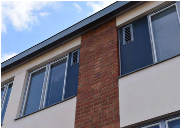
Kuva vasemmalla: Levyillä suljettuja ikkunoita.
