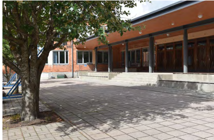
Kuva: Leveä, pylväillä tuettu ja alapinnastaan laudoitettu sadekatos (rakenteita uusittu) korostaa hienosti sisäpihan perällä, väliosassa, sijaitsevaa pääsisäänkäyntiä.
