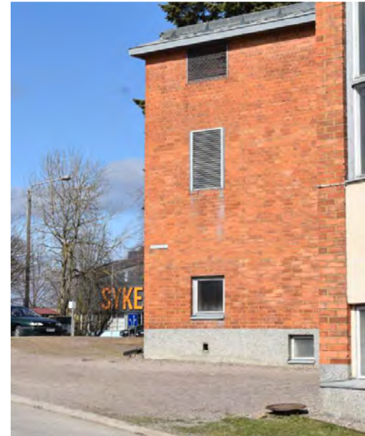
Kuva: Välisosan päädyistä on suljettu ikkuna.
