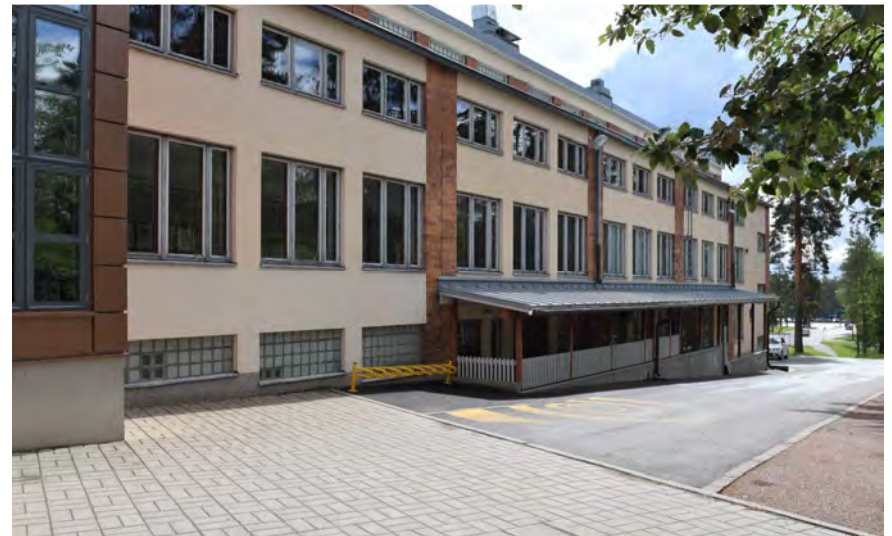
Kuva: Koulun itäsiiven pihafasadiini on lisätty matala pulpettikatos.
