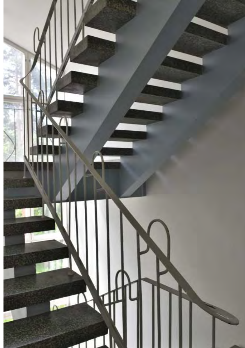
Kuva: Länsisiiven eteläpäädyn porrashuone, johon tulee luonnonvaloa korkeasta lasi-ikkunasta.
