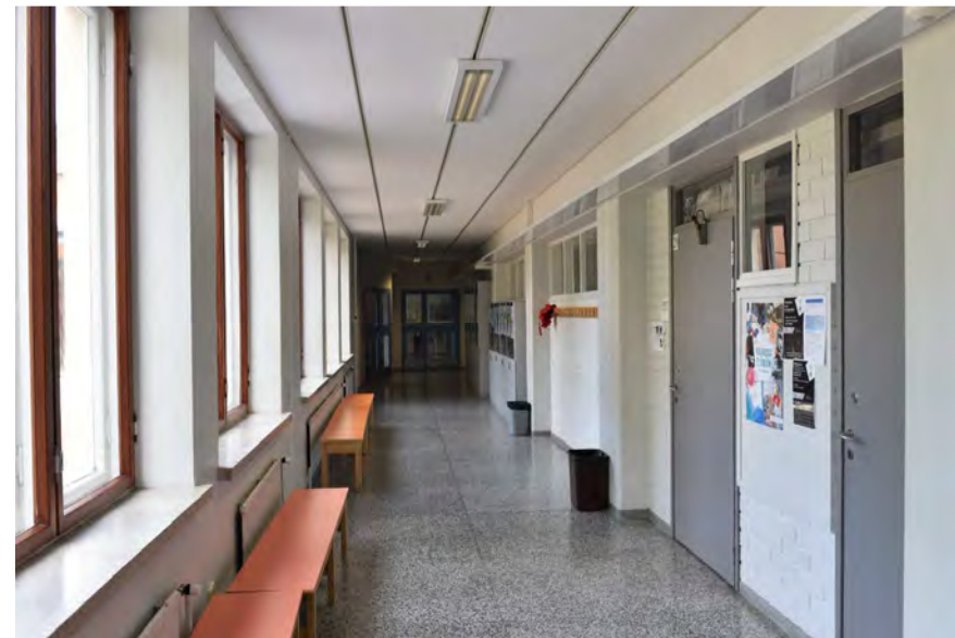
Kuva: Itäsiiven pääkerroksen sivukäytävässä lattiat ja ikkunapenkit ovat mosaiikkibetonia. Ikkunoita on myös väliseinässä ja ovien yläpuolella.
