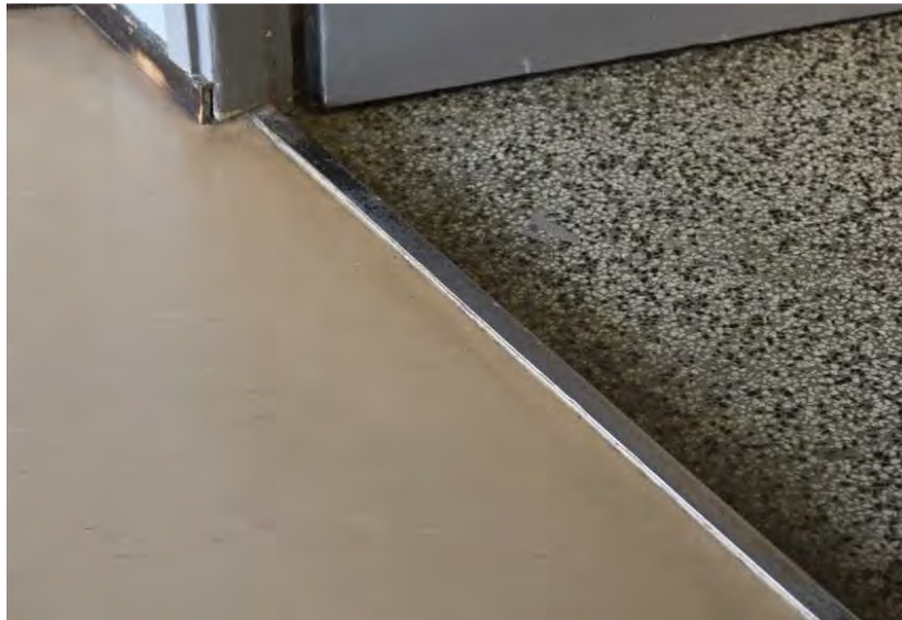
Kuva: Länsisiiven pääkerroksen lattiamateriaaleja, mosaiikkibetoni ovat käytävän päällysteenä. Lattialistat ovat luokkahuoneen puolella puuta ja käytävän puolella muovia. Kynnys on metallia.
