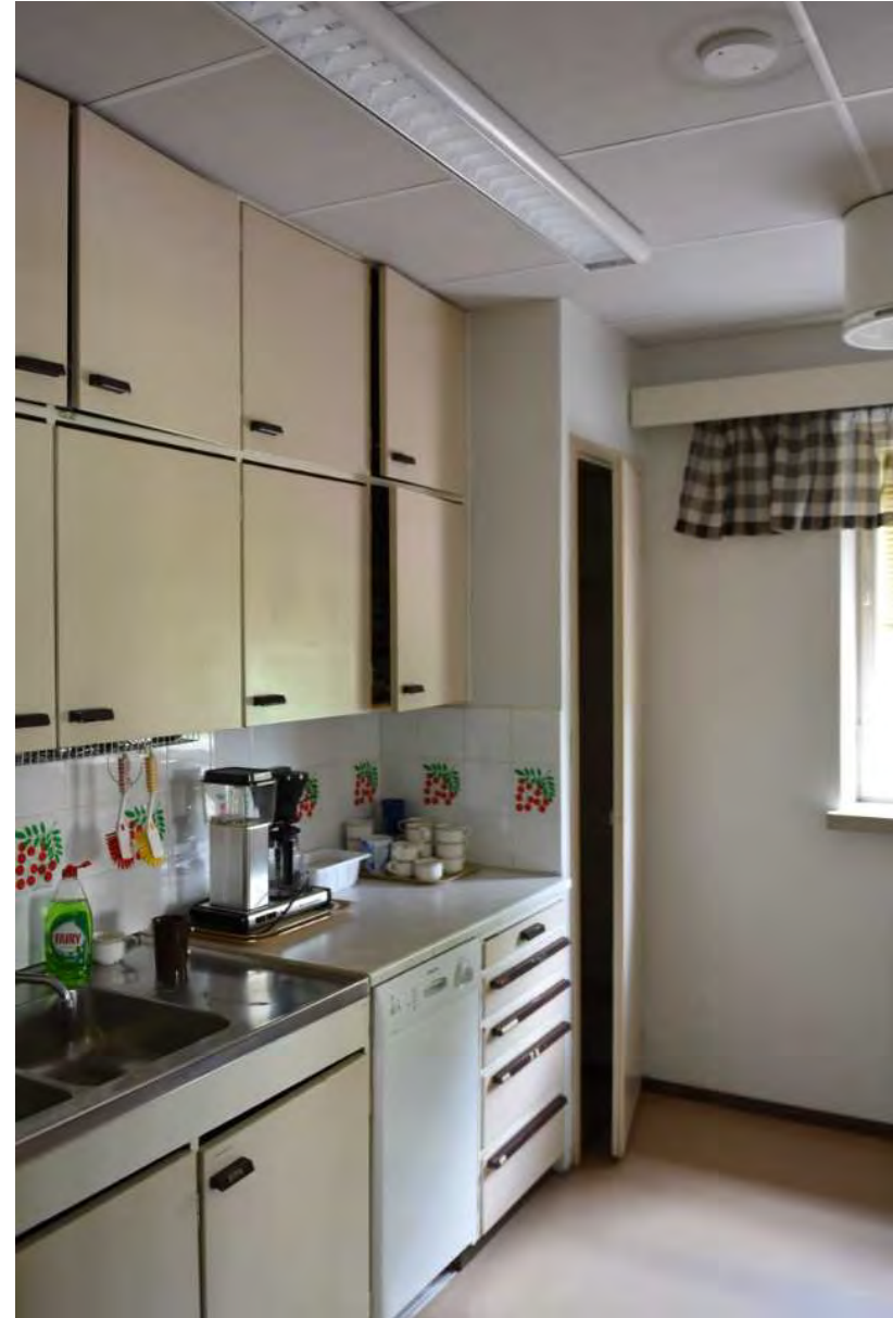
Kuva: Toisen asunnon keittiössä on uusittu pintoja (katto, taso mm.), mutta kaapit ovat vanhat, samoin kaakelointi.
