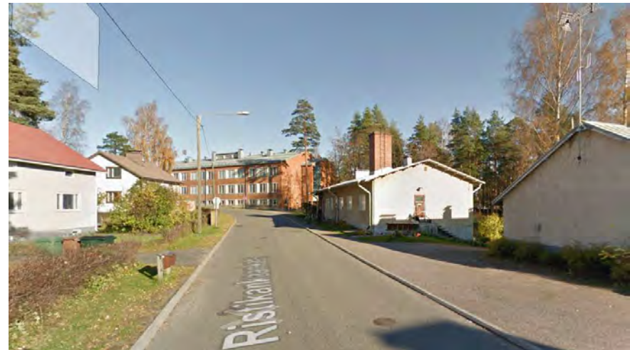
Kuva: Koulun länsisiipi on Ristikankaankadulta avautuvan näkymän pääterakennuksena. Eteläpäädyssä ulkonevassa osassa on porrashuone. / Google StreetView (9.5.2017)
