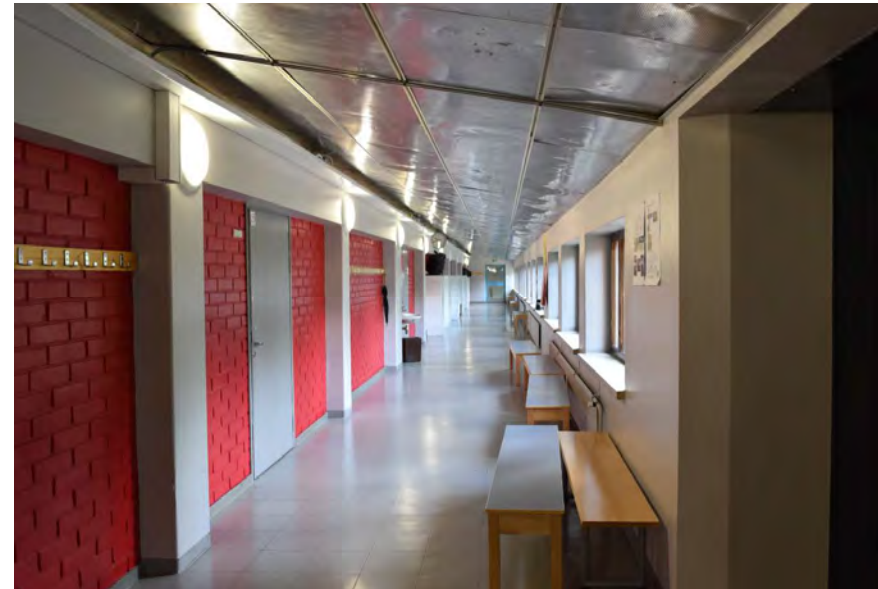
Kuva: Itäsiiven yläkerroksen matala sivukäytävä, jossa uudet vahvat värit korostavat siiven runkorakennetta ja materiaaleja (peittomaalattu tiiliseinä, pilarit ja pitkittäispalkki).
