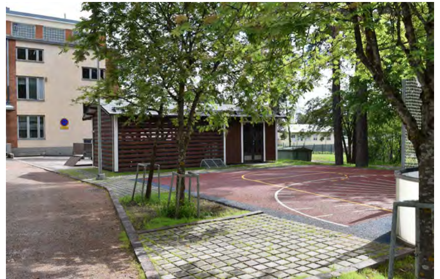
Kuva: Alapihan varistorakennus.
