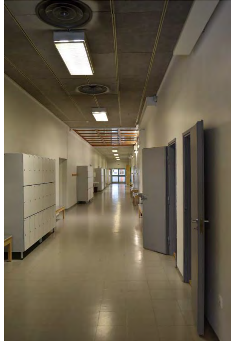
Kuva: Länsisiiven yläkerroksen keskikäytävän katossa on iso ruutuikkuna (maitolasia), joka on yhteydessä ullakolle tehtyyn lasitiili-ikkunalliseen valokuiluun (katolle kertyvä lumi ja sisätiloissa pölyn kerääntyminen lasin yläpinnoille heikentävät ikkunan merkitystä). Seinät on rapattu ja maalattu. Kattolevyt ovat tummuneet. Pitkien käytävien päihin on sijoitettu luonnonvaloa antavat lasiovet.
