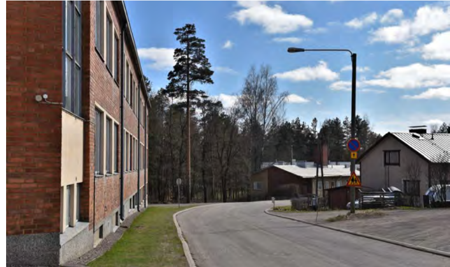
Kuva: Kookas koulurakennus on vahva tilanjakaja keskustamaisen rakentamisen ja pientalovaltaisen asutuksen välissä.
