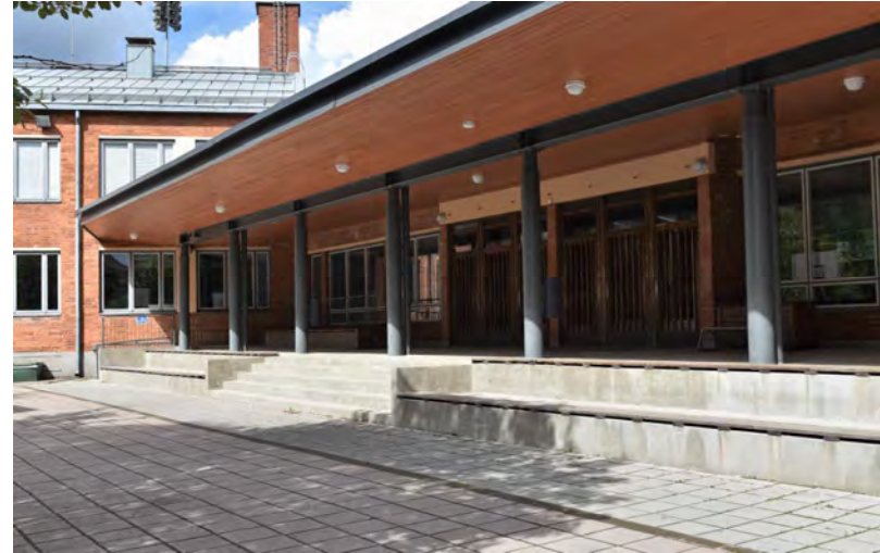
Kuva: Rakennuksen erityispiirteisiin kuuluva sadekatos on pääsisäänkäynnin kohdalla. Alkuperäinen betonista valettu katto on uusittu puurakenteisena 2010-luvulla. Samalla vanhat kantavat betonirakenteet, palkki ja pilarit, on korvattu teräsrakenteilla. Uuden katoksen alapinta on peittomaalattua laudoitusta ja vesikate peltiä.
