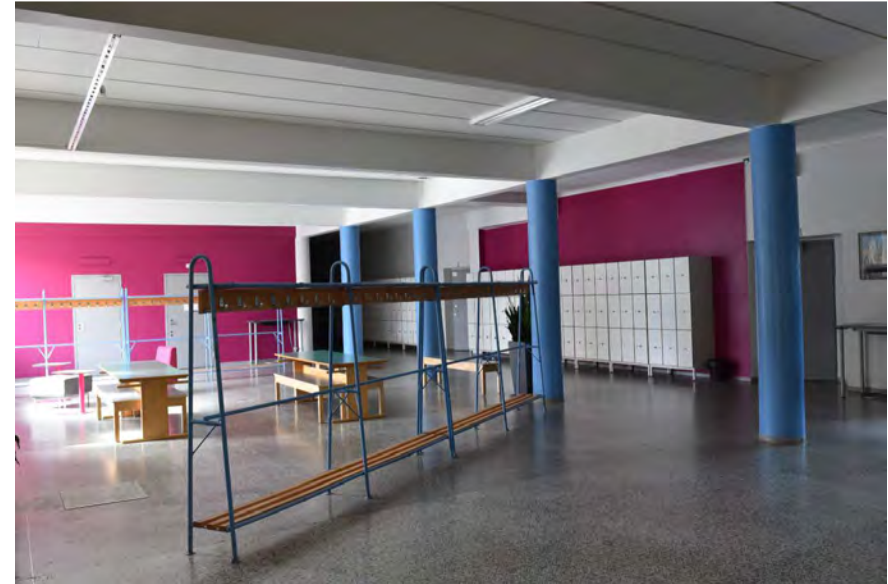
Kuva: Länsisiiven ja välisosan nivelkohdassa, pohjoispään sisäänkäynnin kohdalla, on vaateaula. Tilan värit ja sisustus on uudistettu. Vanhoja elementtejä ovat pylväät, katon palkit ja mosaiikkibetonilattia sekä itsekin isot ikkunat.
