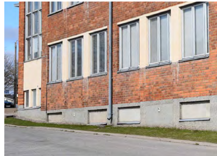
Kuva oikealla: Länsisiiven kellarista on muurattu umpeen ikkunoita.
