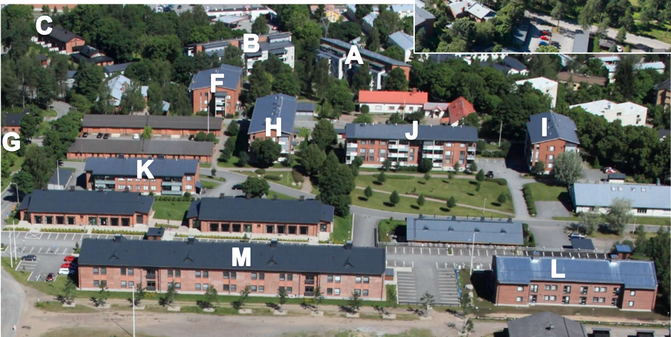
1990-lopun jälkeen rakennettua rakennuskantaa
