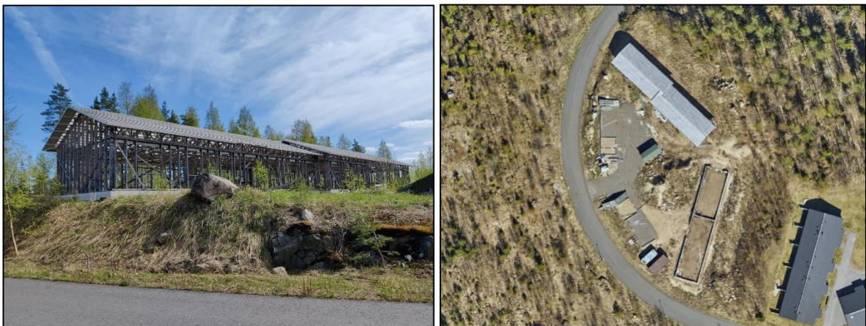
Kuva 22. Kuvassa oikealla näkyy ilmakuvassa kesken jääneet rakennukset. Vasemmalla kuva kesken jääneen rakennuksen seinän runkoa ja katto.
