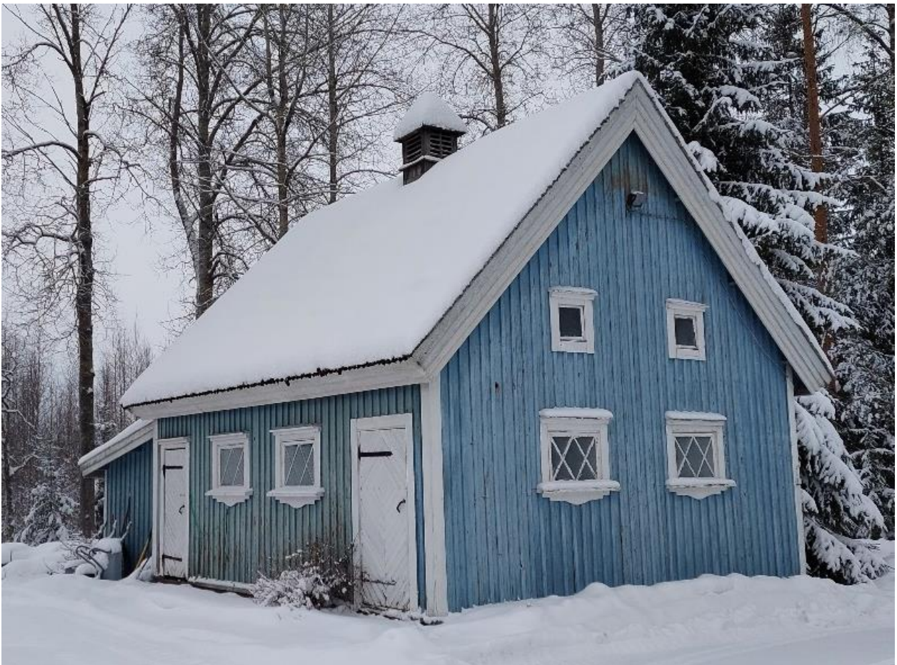
Kuva 29. Kivisaaren avolaitoksen esimiehen asuinrakennuksen talousrakennus
