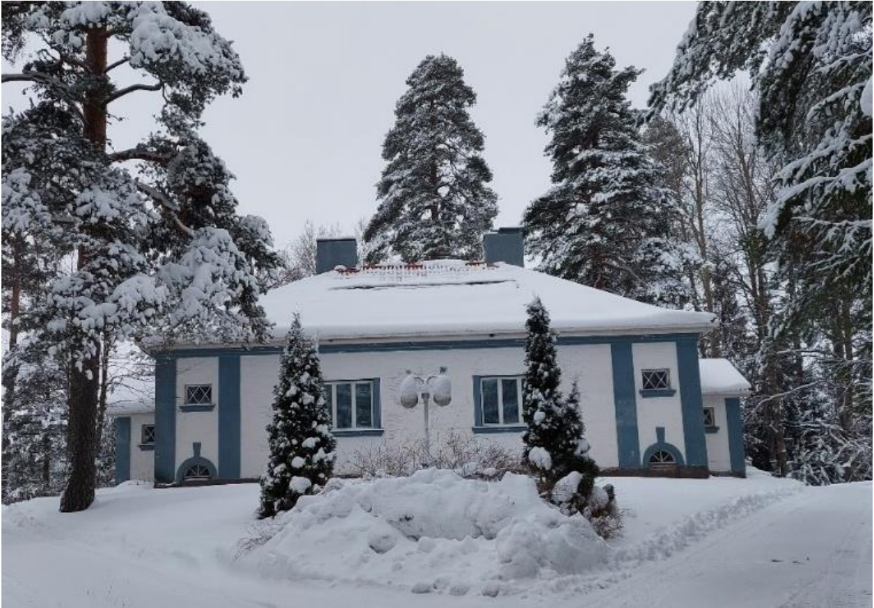
Kuva 28. Kivisaaren avolaitoksen esimiehen asuinrakennus
